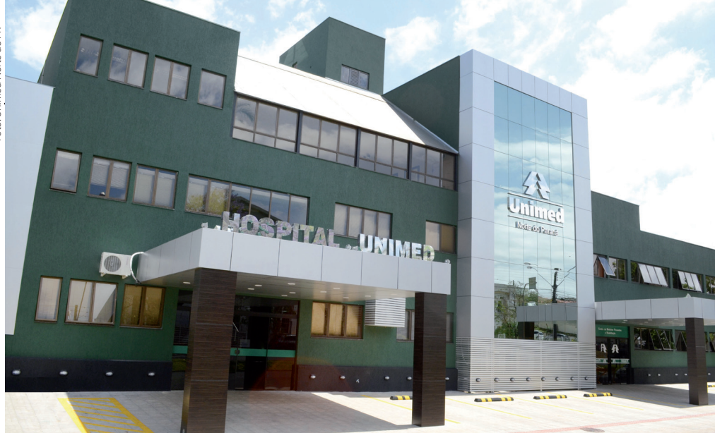
Instalações modernas, equipamentos de última geração e equipes qualificadas: investimento de R$ 10 milhões
