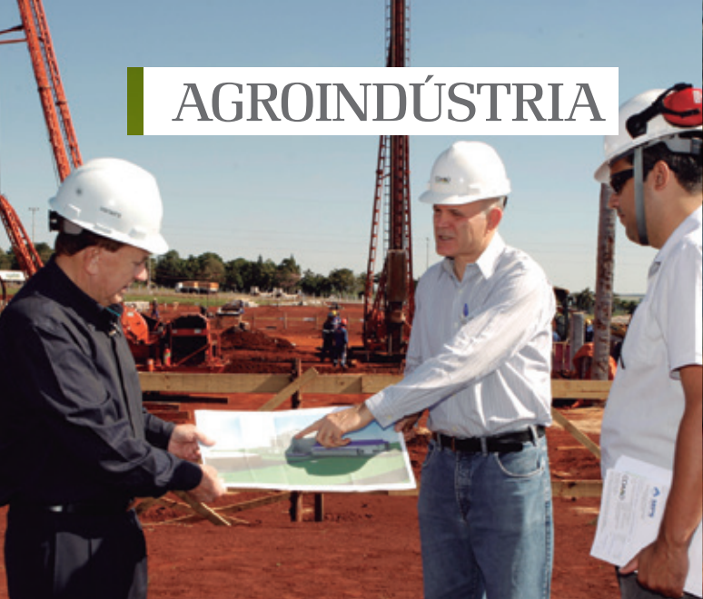
Início das obras do moinho de trigo da Coamo
