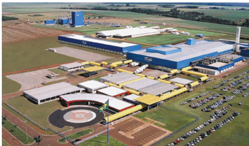
Modernas instalações industriais garantem a segurança alimentar dos produtos processados
