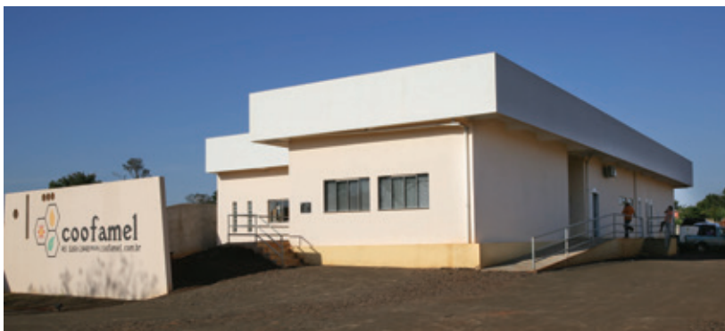
Sede da cooperativa em Santa Helena: investimento de R$ 1,3 milhão possibilitará lançamento de pelo menos oito produtos
