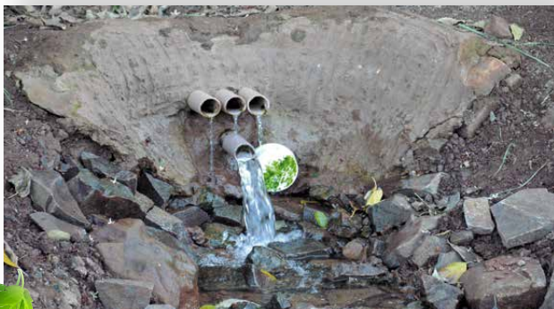
Mistura de argamassa e barro e canalização protege vertentes de água nas propriedades de produtores cooperados
